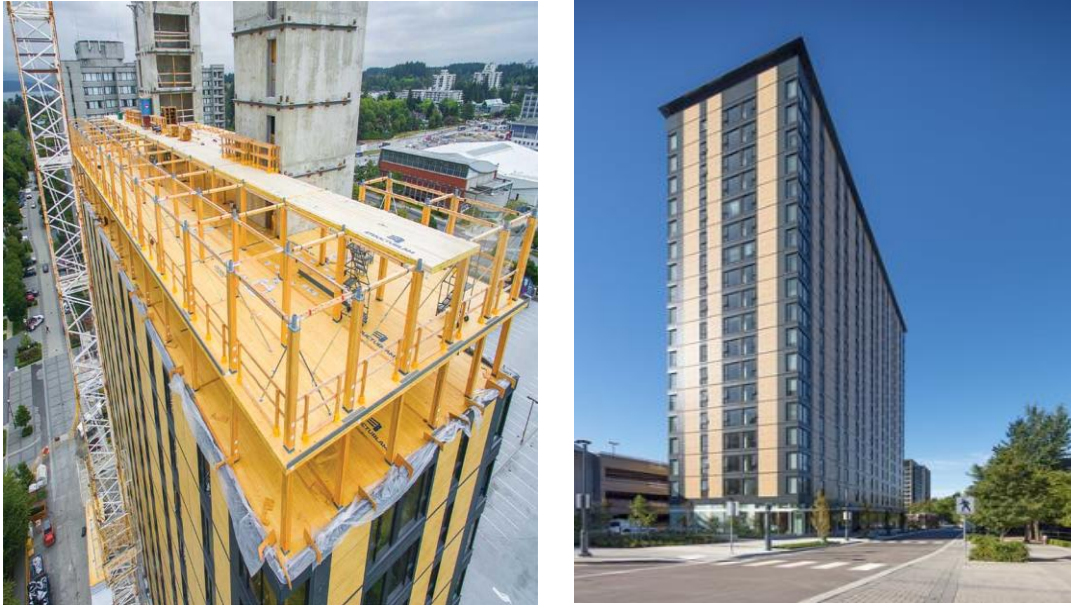
Figura 1.1 - Edifício em CLT
