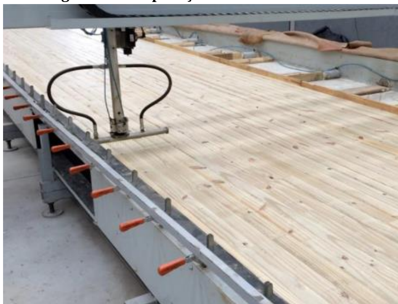
Figura 2.20 - Aplicação do adesivo estrutural
